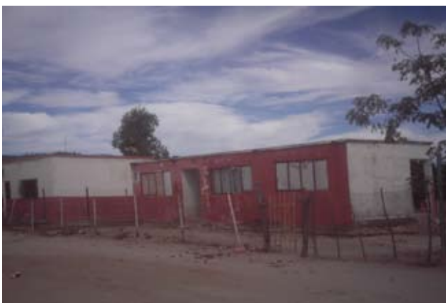
Edificio del dispensario médico
